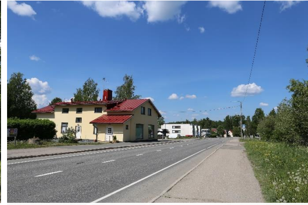
Näkymä Läyliäistenraitilta Seuralan edustalta kohti pohjoista (Kartalla: Puutteellinen valaistus jalankulku- ja pyörätiellä / tien länsilaita). Keltainen rakennus kuuluu Asemakylän arvokkaaseen taajamatilarajaukseen.
