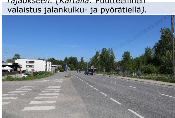
Näkymä Läyliäistenraitilta Väanteenmäentien risteyksestä kohti pohjoista (Kartalla: Puutteellinen valaistus jalankulku- ja pyörätiellä).
