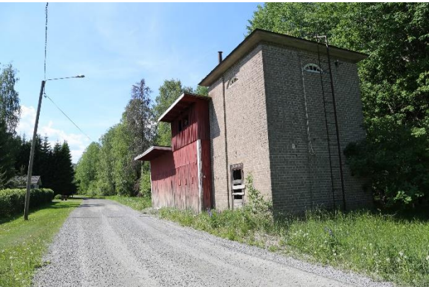
Entisen rautatien varren vesikopilla, joka oli talvisinkin lämmitetty, tankattiin junien höyrypannuja.
