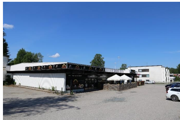
Nykyinen ravintola Bar Parooni sijaitsee 1966 rakennetussa entisessä myymälärakennuksessa, jonka päädyssä oli myös kahvila.
