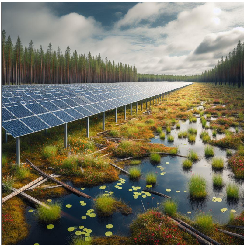
Kuva 23. Esimerkki viivytytsaltaasta aurinkopuistossa.
