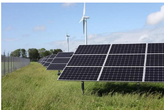
Kuva 3. Esimerkki piipohjaisista aurinkopaneelimoduuleista alumiinirungossa maapohjaisessa telineessä (vasemmalla). Oikealla esimerkki yksiakselisista seurantalaitteista aurinkopaneeleille.
