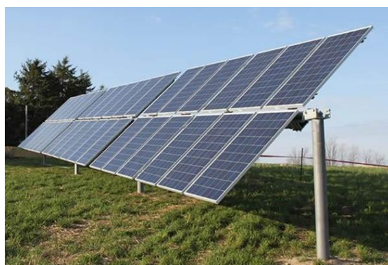
Kuva 3. Esimerkki piipohjaisista aurinkopaneelimoduuleista alumiinirungossa maapohjaisessa telineessä (vasemmalla). Oikealla esimerkki yksiakselisista seurantalaitteista aurinkopaneeleille.
