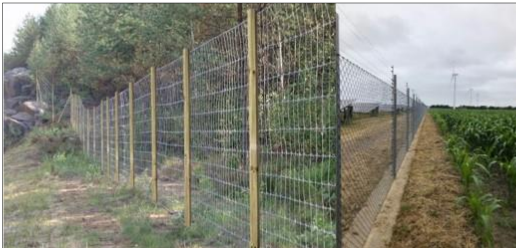
Kuva 2 Esimerkki riista-aidasta, jossa on puutolpat (vasen kuva), ja teollisuusverkkoa sisältäen sisäisen ylityssuojan sähkölangalla (oikea kuva)
